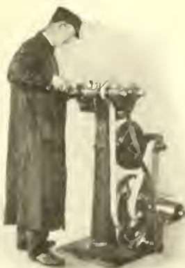
26. Heel Trimming Machine
